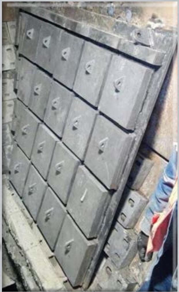
Liners autobloquants installés en position en utilisant une plaque d'appui préassemblée en atelier
